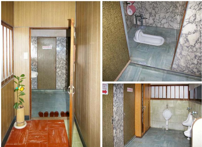
改修前トイレ
