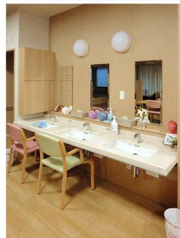
椅子に座って洗顔や歯みがきができるように、洗面カウンターは足元をオープンにしている。水栓金具は衛生面に配慮し、ノンタッチで水の出し止めができる自動水栓を採用。
