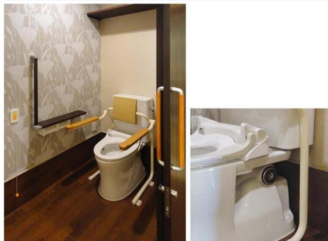
前出寸法がコンパクトなパブリックコンパクト便器は、詰まりに備えて掃除口付きタイプを採用。使用中の座位の安定を図るために、背もたれ付きのアームレストを設置している。
