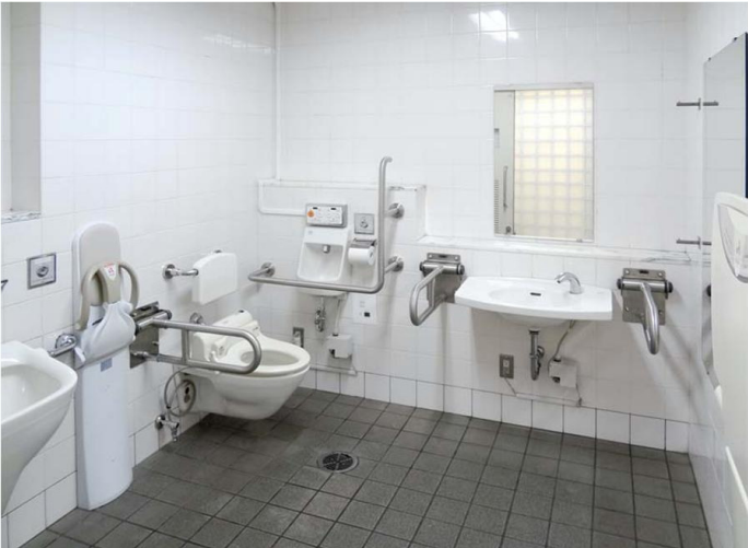
2005年に改修した多機能トイレ。車いす使用者や小さなお子様連れ、オストメイトの方など、さまざまな使用者に配慮して、汚物流し・ベビーシート・ベビーチェアを完備している。
