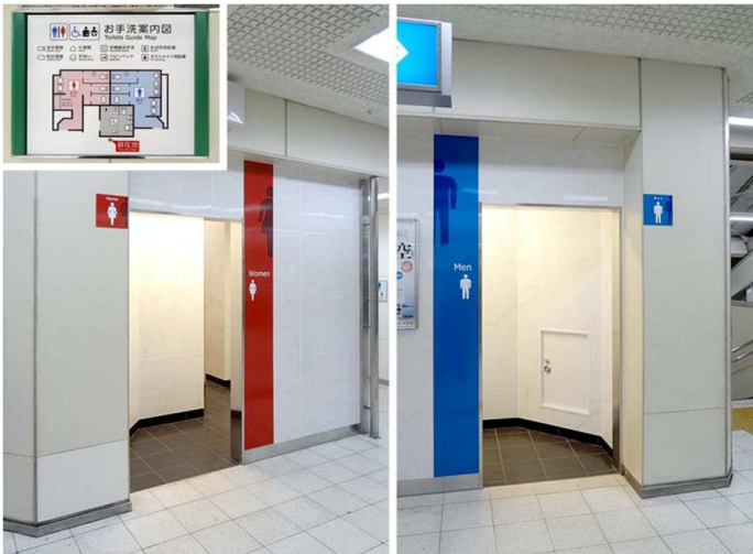
バリアフリー配慮として、段差をなくしたトイレ入口。入口には、視覚障がい者の方が、トイレ内の設備を確認できる触地図を掲示している。
