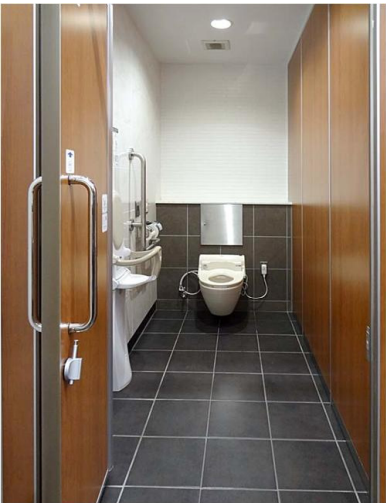
小さなお子様連れに配慮し、ベビーカーごと入ることができる、ベビーチェアを備えたひろびろブースを男女トイレに1ヶ所設置。ドアは開口部を広く確保できる折戸を採用している。
