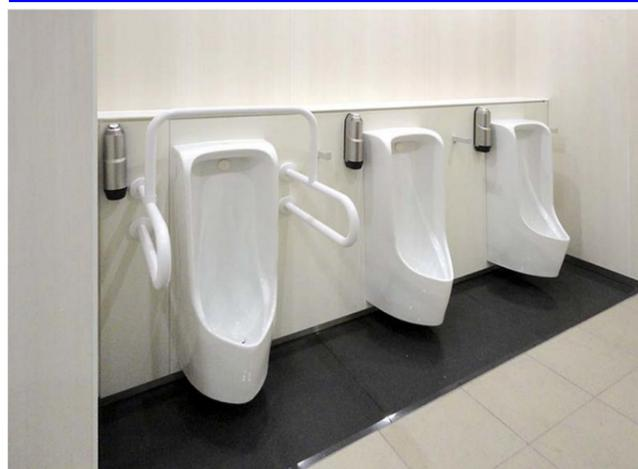
マイクロ波センサータイプの壁掛式低リップ小便器を採用。小便器の足下には、尿の飛散によるにおいや汚れを軽減する、ハイドロセラ・フロアPUを設置している。
