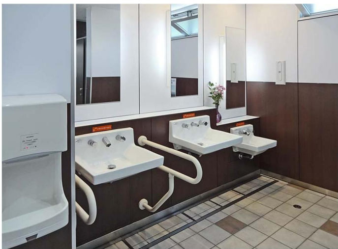
女性トイレ同様、小さなお子様使いやすい高さの洗面器を用意している。
