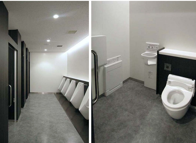
RESTROOM ITEM 01の小便器の足元には尿の飛散による汚れやにおいを抑えるハイドロセラ・フロアPUを採用。男女トイレともベビーチェアやフィッティングボードなどを備えた広めの大便器ブースを完備。
