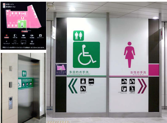
トイレ入口の目隠しを兼ねたサインには、内部の設備がひと目でわかるように表示。触知図もあわせて掲示している。
