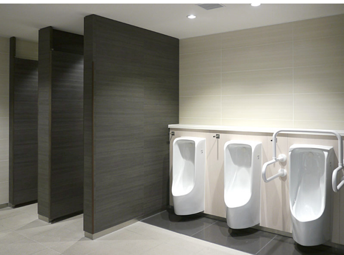
インテリアはシックで落ち着いた雰囲気統一。小便器は子どもから大人までラクに使用できる、マイクロ波センサー内蔵の壁掛式低リップタイプを採用している。
