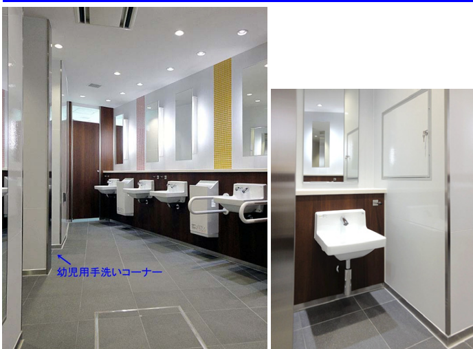
クリーンドライは、手洗い後の床への水垂れを抑えるために、洗面器の間に設置。また、お子様がいしやすい高さに洗面器を設置した、幼児用手洗いコーナーも用意。
