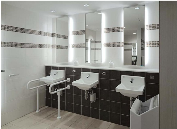
女性トイレ 洗面コーナー
