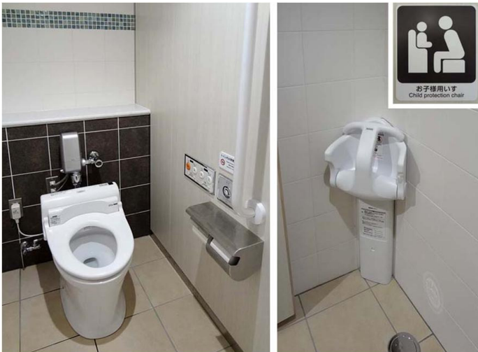
男性トイレ 大便器ブース
