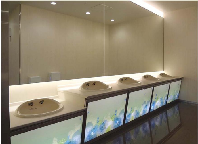
小さなお子様が使いやすいように、洗面器の1ヶ所は低めに設置。 クリーンドライも高さを変えて取り付けている。洗面カウンターの フロント部には、ロビーと同じイメージの花びらをデザインしている。
