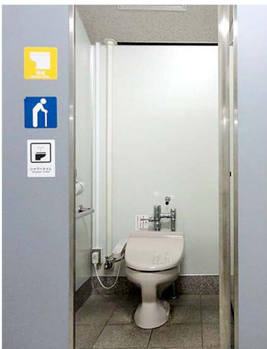
洋式便器の一部にはウォシュレットを設置。
