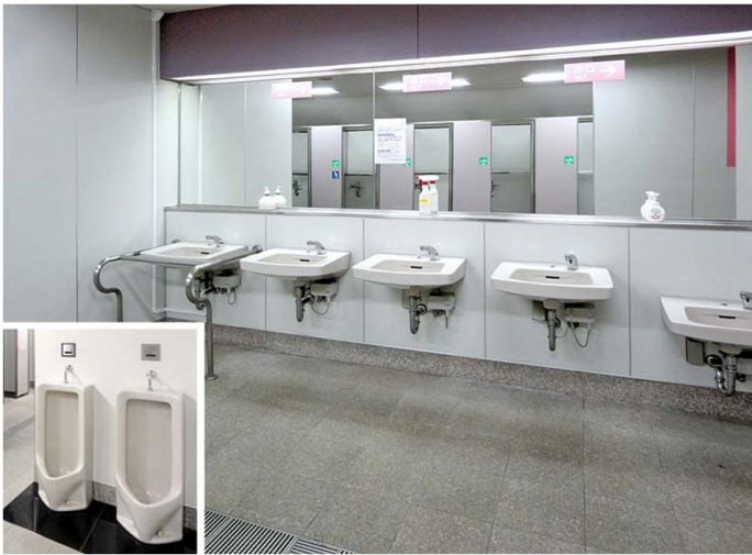
洗面器の内1ヶ所は、小さなお子様がいやすいように560mmの高さに設置している。また、女性トイレの洗面コーナーの近くには、お子様用の小便器コーナーも用意している。
