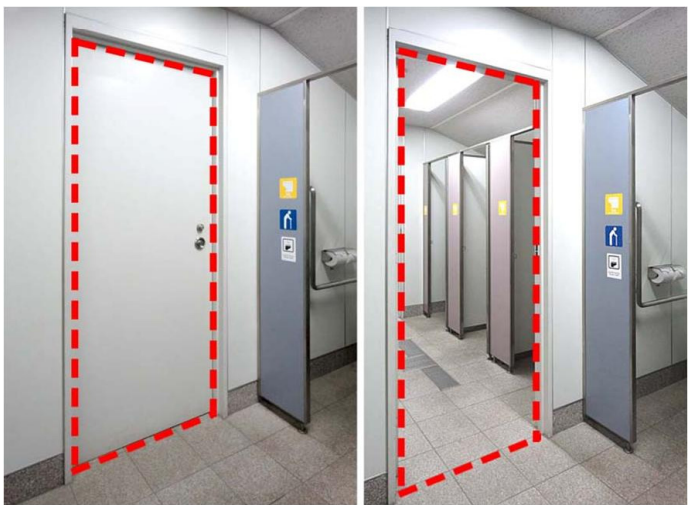
イベントにより来場者の男女比が異なる場合を想定して、トイレ内に可変壁を設け、男女の大便器のブース数を調整できるようにしている。可変壁の扉を開けることで大便器のブース数の男女比が変えられる。
