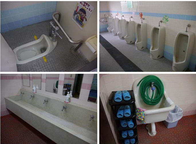
改修前トイレ
