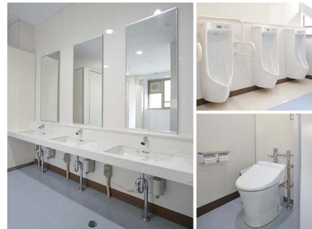
環境への配慮として、水栓金具は止め忘れがない自動水栓、大便器は津市立小学校基本仕様の6L洗浄の節水便器、照明器具は節電効果のある人感センサー式を採用している。
