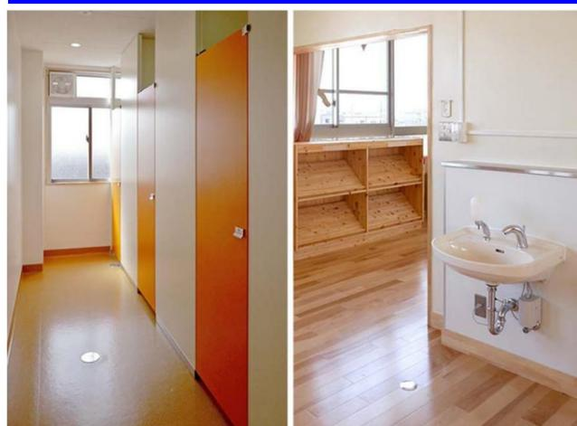
床を乾式化とすることで毎日の掃除も容易に。においも軽減し、ブース材の老朽化も抑えられる。またトイレ以外の水まわりも自動水栓とし、衛生面や節水性に配慮した（写真は3F図書室の水まわり）。
