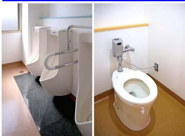
大便器と小便器も衛生面と節水性に配慮し、自動洗浄タイプを採用。大便器はオートクリーンCとの組み合わせで洗浄水量5.5Lを実現。小便器はジアテクト機能により、尿石の付着やにおいの発生も抑制。
