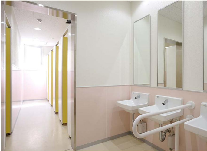
2F 女子トイレ 全体
