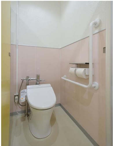
2F 女子トイレ 大便器ブース
