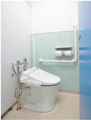
2F 男子トイレ 大便器ブース
