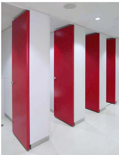
女性トイレ 大便器コーナー
