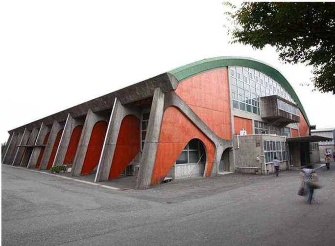
曲線フォルムの傾斜した控え柱と打ち放しコンクリートと赤土色の塗装の組み合わせが、モダンでダイナミックな印象を与えている。
