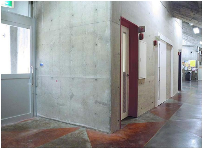
車いす使用者に配慮して、トイレ左側にスロープ付きの入口を新設。男女トイレを入れ替えたため、サインの掲示に加えてドア枠も色分けし、混乱を防いでいる。
