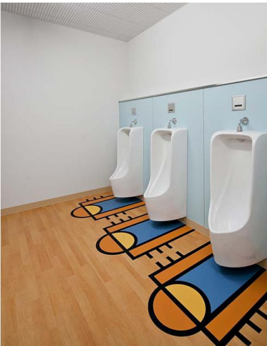
体育館 男子トイレ 小便器コーナー
