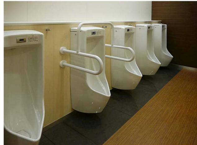
床の清掃性や節水性に優れた壁掛式の自動洗浄小便器を採用。小便器の間には傘などが掛けられるフックを取り付けている。
