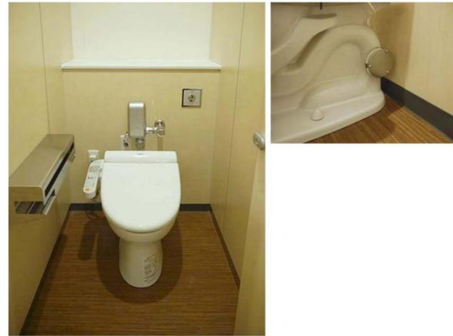
誤って携帯電話を落とした場合などの便器詰まりに備えて、掃除口付便器を採用。男女トイレともすべての大便器に音姫(擬音装置)機能を搭載したウォッシュレットPを設置し、2度流しを防止している。
