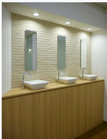
歯みがきコーナーにはベッセル式の手洗器と自動水栓を採用。カウンターは口をすすぎやすい高さに設定している。
