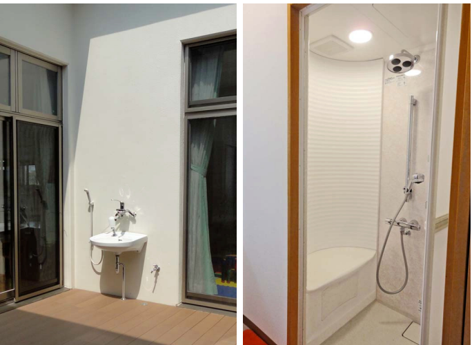
(左) 水浴びができる中庭のデッキ。手洗器を設けているため、汚れた手足を洗って直接保育室に入ることができる。(右) 園児と遊んだ後、保育士が汗を流せるように、シャワールームを設置している。
