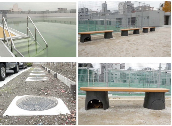
屋上プールの水は、災害時に消防用やマンホールトイレ（10基）の排水として活用。また6000食分の食料と蓄電装置を保管できる備蓄倉庫を備え、校庭には、かまどとして利用できる“かまどベンチ”も設置。
