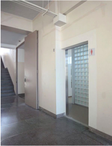
トイレが密室にならないように入ロドアをなくし、ガラスブロックのパーティションで目隠ししている。ガラスブロックを通して内部の人の気配が感じられる。
