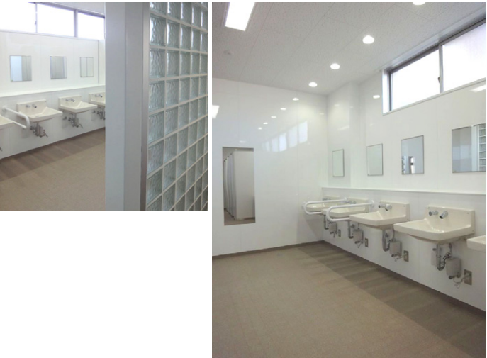
洗顔もできる大きさの壁掛洗面器を設置。ノンタッチで水の出止めができ、水じまいのよい壁付タイプの自動水栓を採用している。アンケートで要望が多かった水石けんや全身鏡も設置している。
