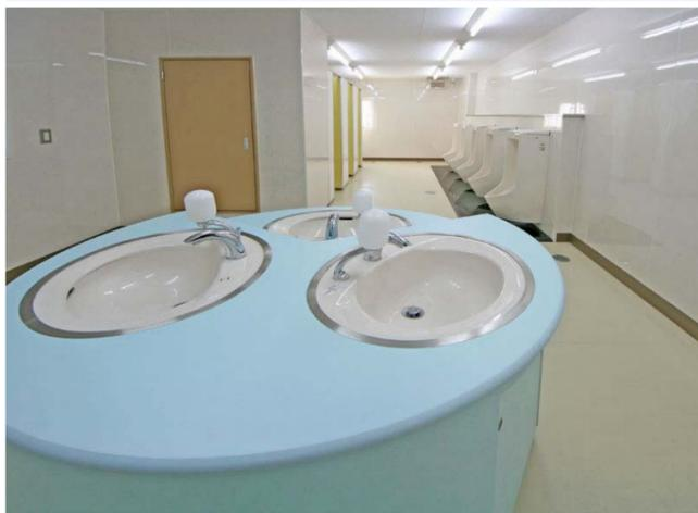
子供たちが楽しく集えるように、アイランドタイプの洗面コーナーを設置。衛生面や節水性に配慮し、自動水栓を採用。低リップタイプの壁掛小便器の床にはハイドロセラ・フロア(おだれ陶板)を設置し、清掃性にも配慮している。
