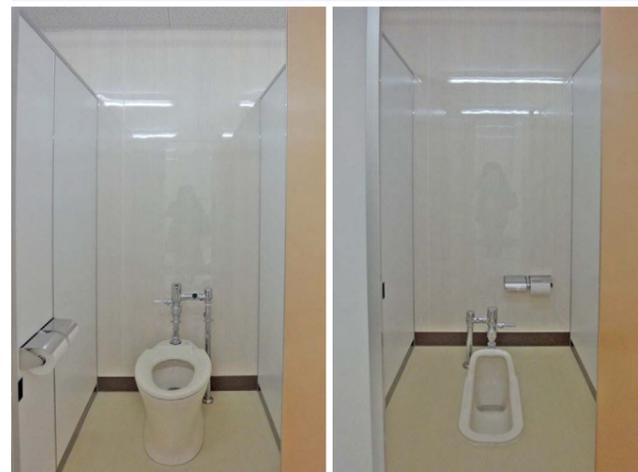
6L洗浄・フチなし形状・トルネード洗浄の機能を備え、節水性や清掃性に優れたパブリックリモデル便器を採用。男女トイレに各1ヶ所ずつ、和式便器を設置している。
