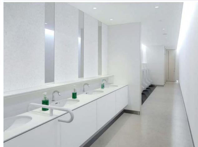
自動水栓を採用した洗面コーナー。衛生面に配慮した非接触タイプで、節水効果もある。
