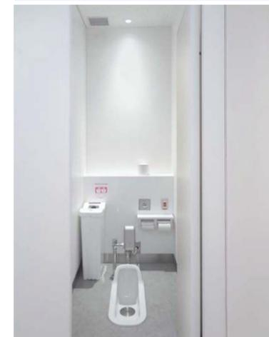
防犯対策として間仕切り壁上部の隙間をなくし、個室感を高めている。また環境配慮として、人感センサー式のLED照明を採用している。
