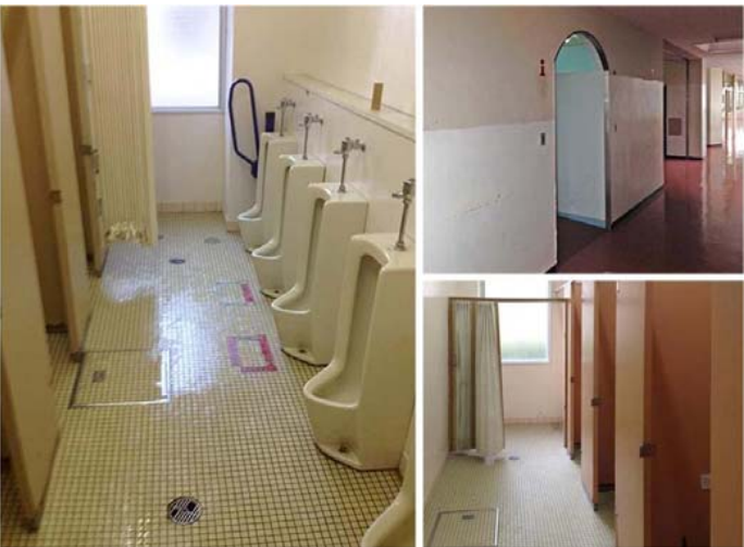
改修前トイレ
