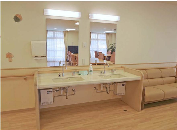
車いす使用者がアプローチしやすい形状の洗面カウンター。お湯が使えるように小型電気温水器を備えており、冬も快適に利用できる。
