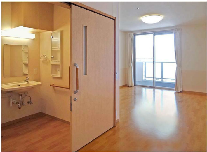
すべての居室に、トイレと洗面所を完備している。車いす使用者に配慮して、開口部が広く確保できる引戸を採用。
