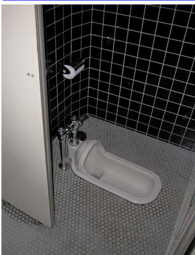
和式便器の男女兼用トイレだった。タイル張りの床は、掃除をしても目地の汚れが落ちないなどの問題があった。
