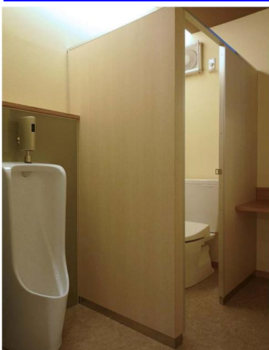
小便器には、自動洗浄システムのオートクリーンUを採用。間接照明により、落ち着いた雰囲気トイレ空間となっている。
