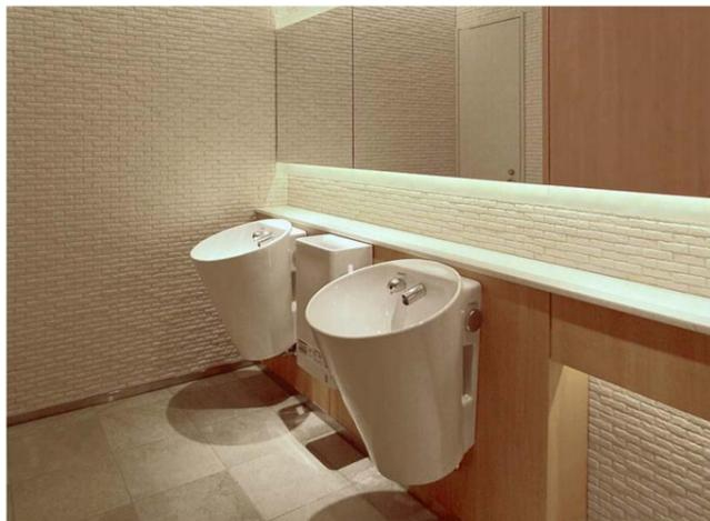
周囲への水はねを防ぐ形状の壁掛自動洗面器を採用。洗面器の間にクリーンドライを設置し、手洗い後の床への水垂れも抑えている。洗面器コーナーの隣はパウダーコーナーとなっている。
