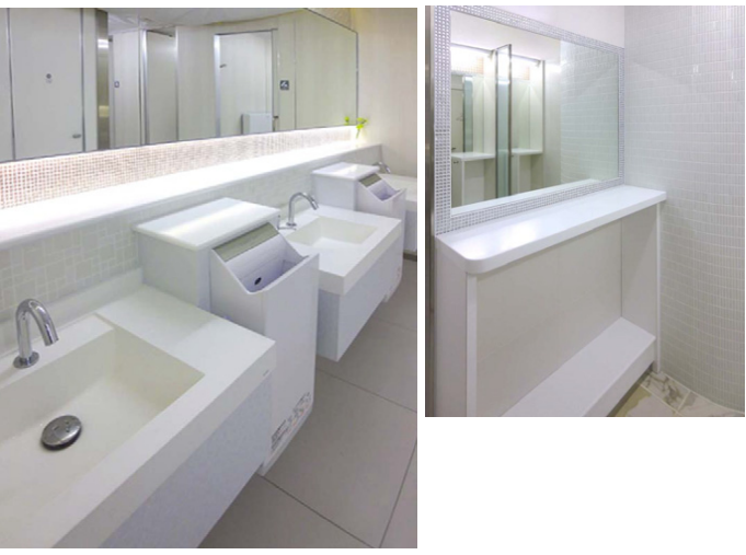
手洗いの水で床が濡れないように、洗面器の間にクリーンドライを設置。パウダーコーナーは2ヶ所に設け、足元に荷物が置けるカウンタータイプと、間仕切りで個室感を高めた2タイプを用意している。
