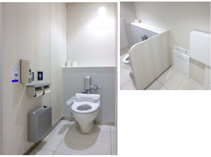
2度流しを防止するために、音姫(擬音装置)機能を搭載したウォシュレットPを採用。ひろびろブースには、大便器横に間仕切りを設け、ペーパーシートとフィッティングボードを設置している。
