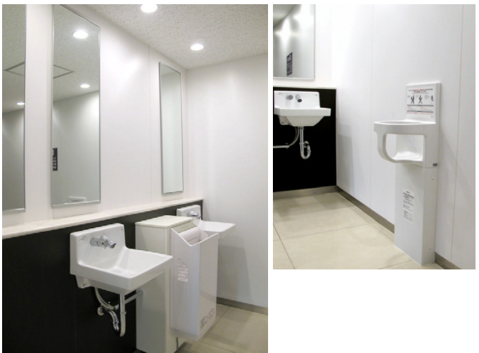
手洗い後の水で床が濡れないように、洗面器の間にクリーンドライを配置。また、お子様連れの方に配慮して、洗面コーナーにもベビーチェアを設置。
