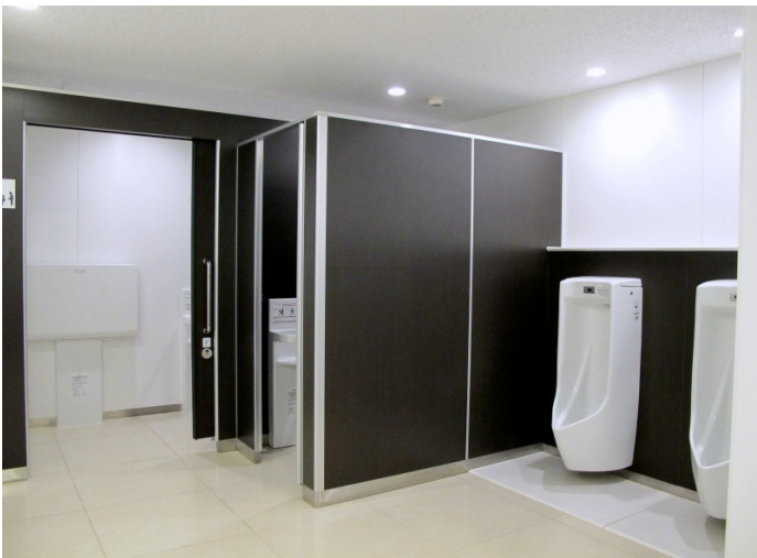
小便器の足元には尿の飛散による臭いや汚れを防ぐハイドロセラ・フロアを設置。ベビーカーゴと入れる広めの大便器ブースには、広い開口部を確保するため引戸を採用。
