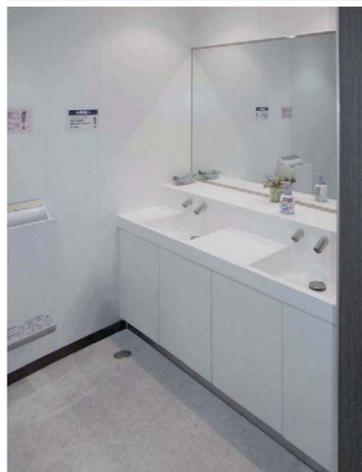
カウンターとボウルとの間に継ぎ目がなく、清掃性に優れたボウル一体タイプの洗面カウンターに、水じまいのよい壁付きの自動水栓を採用。ドライエリアに棚を設け、荷物が濡れないように配慮している。
