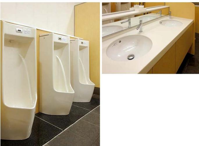
バクテリアの繁殖を抑え、尿石の付着を抑制するジアテクト機能付き小便器を採用。洗面コーナーには、男女トイレともに綿棒やデンタルフロスのなどのアメニティが用意されている。
