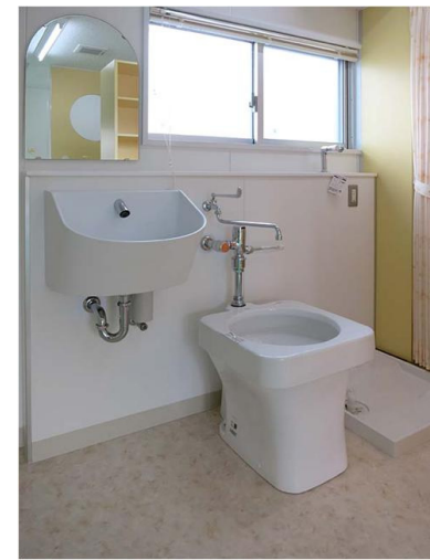
スタッフ用手洗器と汚物流しを設置。主に同伴の保護者が、トイレサポートをした後に使用している。
