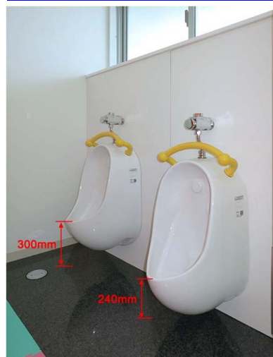
小便器も園児の体格にあわせて選べるよう、240mm・300mmの高さ違いで設置している。小便器の足元には、尿の飛散によるにおいや汚れを軽減するハイドロテクトタイルを採用。
