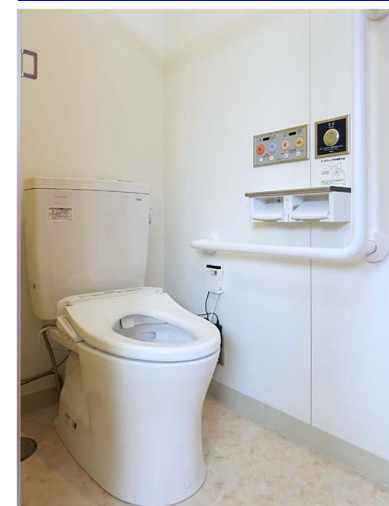
ウォシュレットのリモコンは、操作しやすい大きなボタンのリモコンを採用。便器洗浄もボタンを軽く押すだけでできる。
