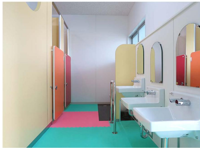
男女別のトイレを男女兼用トイレに変更し、ゆとりあるスペースを確保。床材は転倒してもケガをしないように、柔らかいウレタン素材を採用している。
