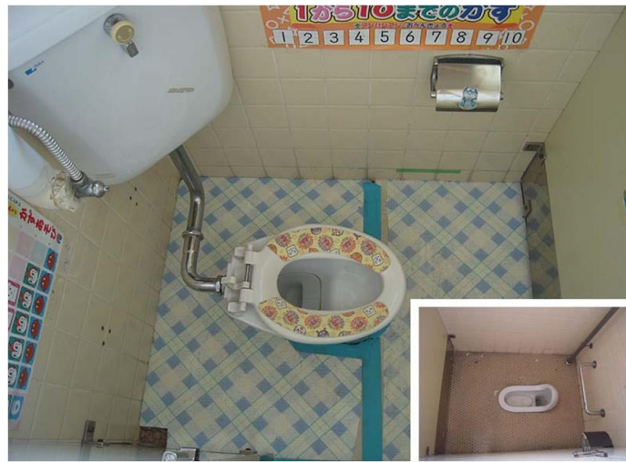
改修前の大便器ブースは、スペースも狭く介助がしにくかった。
